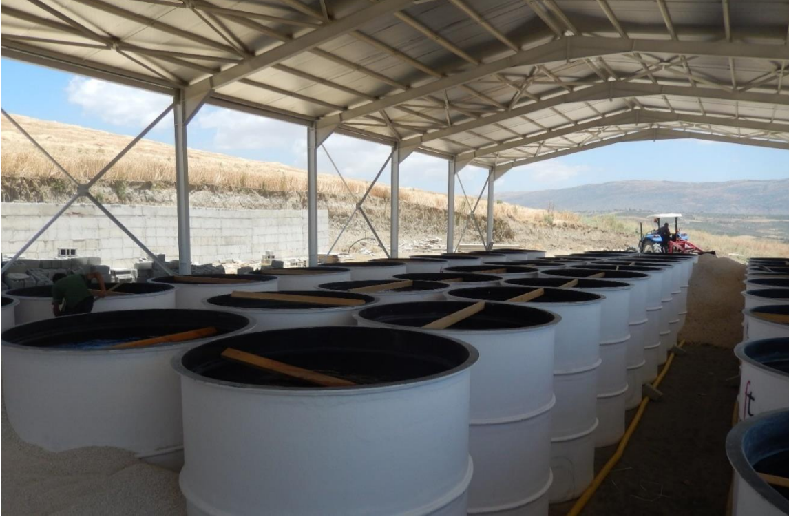
Şekil 6.52. Kurulum aşamasında olan bir sofralık zeytin işleme tesisi
